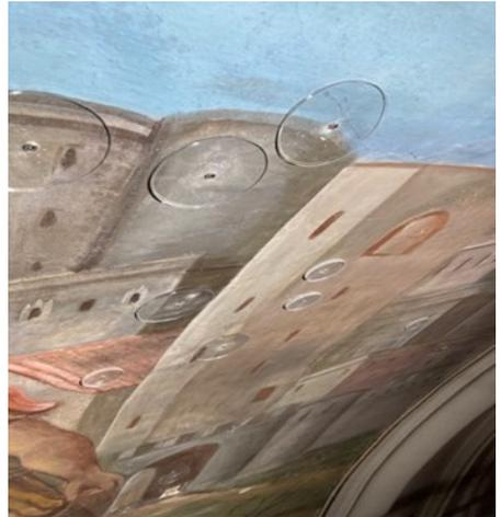
Fotos von der Sicherung der Raumschale (Decke) mit Schrauben und Plexiglasscheiben
